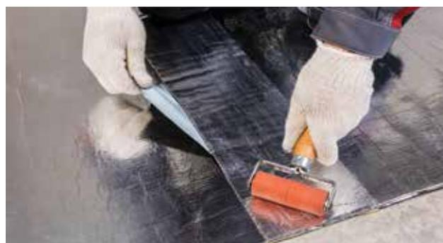
Рис. 4.28. Проклейка швов самоклеящейся лентой-герметиком
