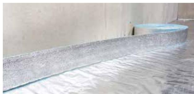
Рис. 4.29. Устройство примыкания
