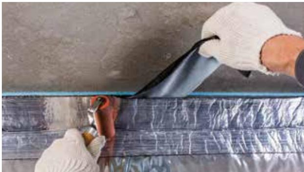
Рис. 4.30. Создание герметичности
