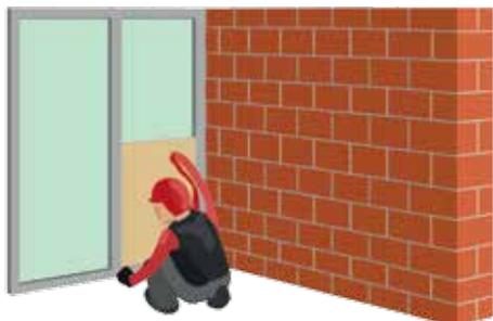
Рис. 4.11. Укладка плит ТЕХНОАКУСТИК
