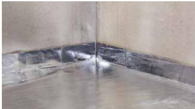
Рис. 4.31. Заведение материала Техноэласт АКУСТИК СУПЕР на вертикальные конструкции
