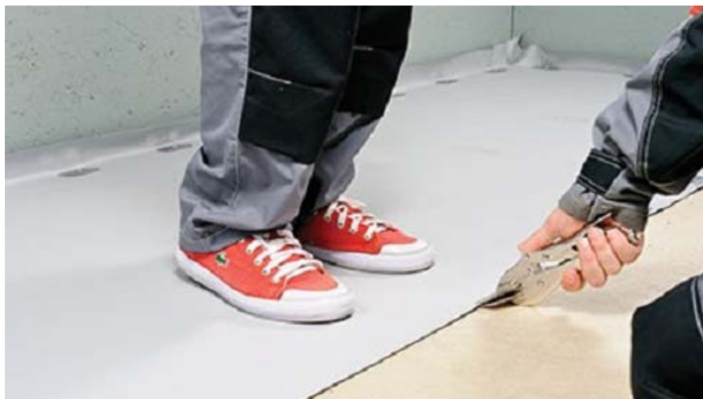
Рисунок 4.20 – Дополнительное натягивание участка мембраны
