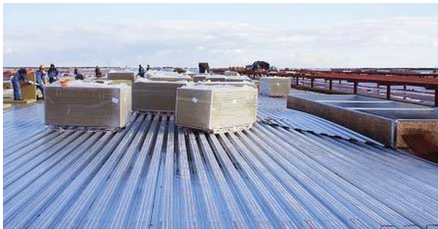
Рисунок 4.4 – Временное складирование материалов на крыше Складирование изделий и материалов на ограниченном участке крыши во избежание деформации основания из профилированного настила не допускается.
