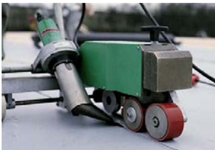
Рисунок 4.24 – Сварка полотен мембраны при помощи автоматического аппарата горячего воздуха
