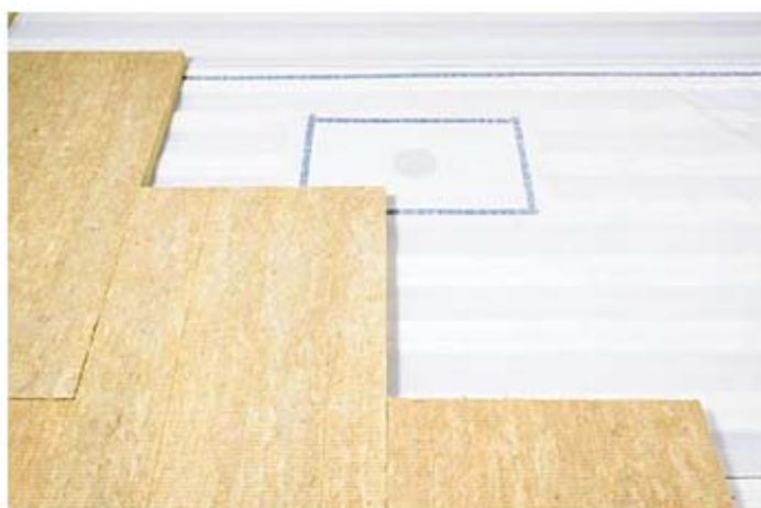
Рисунок 4.8 – Укладка теплоизоляционных плит нижнего слоя
