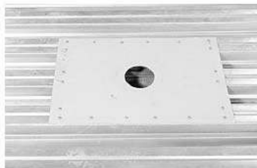
Рисунок 4.5 – Усиление мест сквозных проходов через несущее основание
