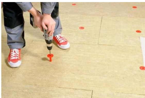
Рисунок 4.16 – Крепление теплоизоляционного слоя к основанию
