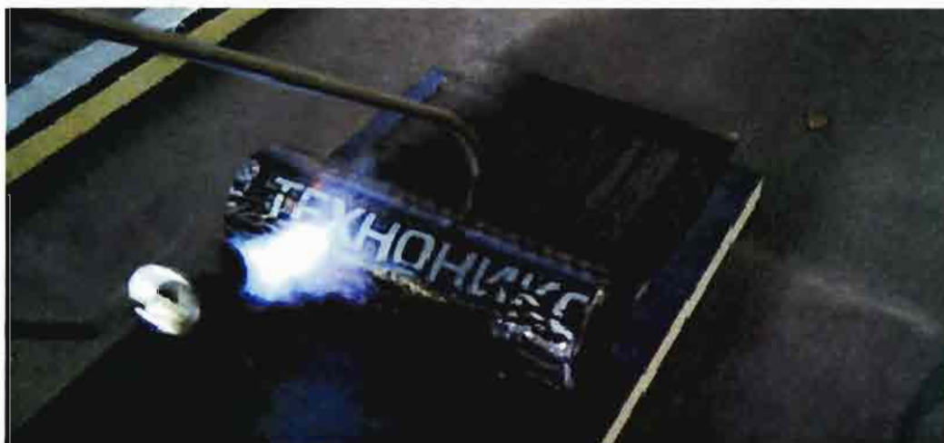
Рисунок 1. Пламя горелки направлено на поверхность рулона
