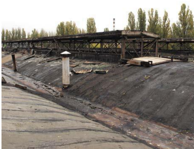
Рис. 5.11 Старая битумная кровля с основанием из ребристых плит
