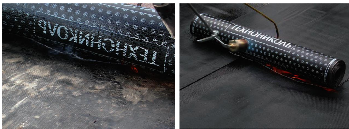
Рис. 5.2 Валик расплавленного битумно-полимерного вяжущего
