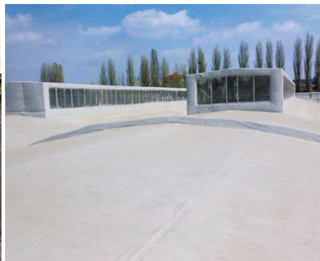
Рис. 5.12 Вид кровли после реконструкции полимерными мембранами с доутеплением плитами PIR
