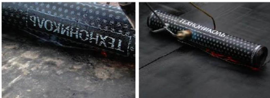
Рис. 5.18 Валик расплавленного битумно-полимерного вяжущего
