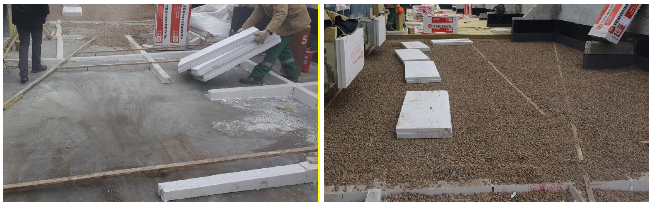
Рис. 5.8. Свободная укладка теплоизоляционных плит и клиновидных плит теплоизоляции без применения клеевых составов
