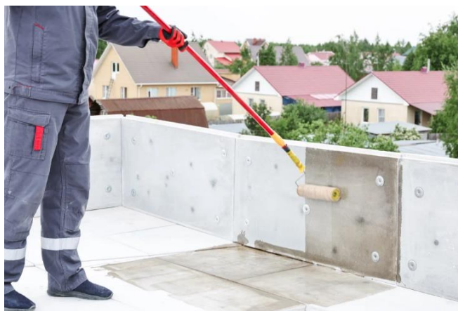
Рис. 5.11 Устройство грунтовочного слоя
