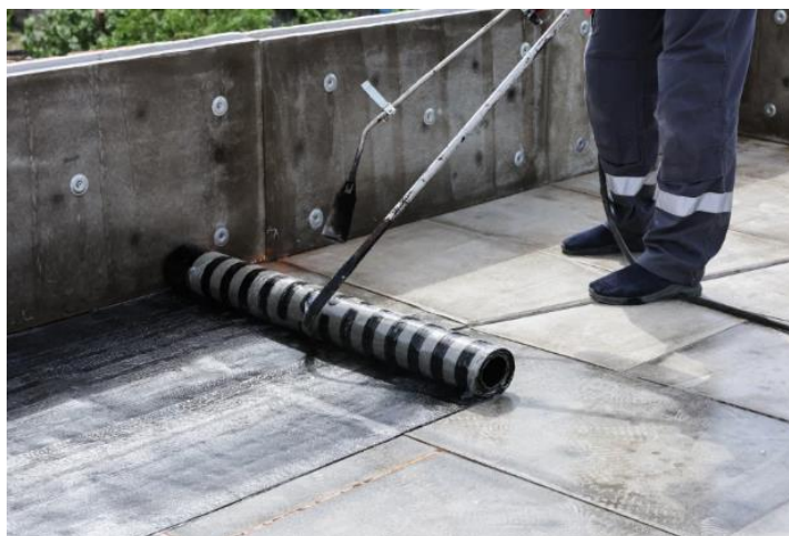
Рис. 5.12 Устройство нижнего слоя водоизоляционного ковра
