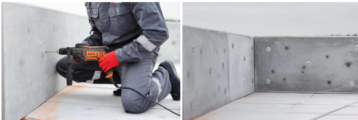
Рис. 5.20 Крепление листовых материалов к вертикальной поверхности
