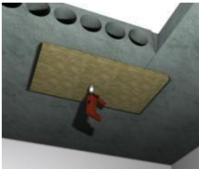
Рис.3. Сверление железобетонной конструкции
