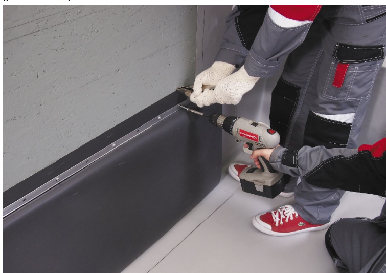
Рис. 5.23 Размещение дополнительной рейки в «кармане»
