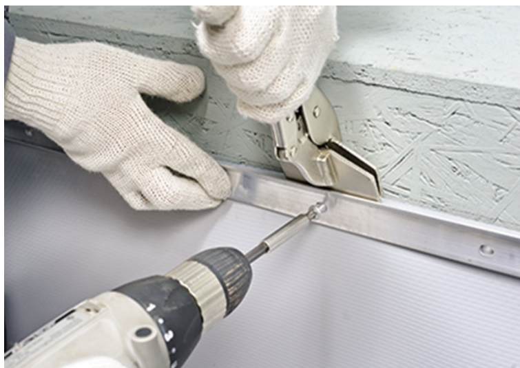
Рис. 5.24 Крепление полотна мембраны при помощи краевой рейки
