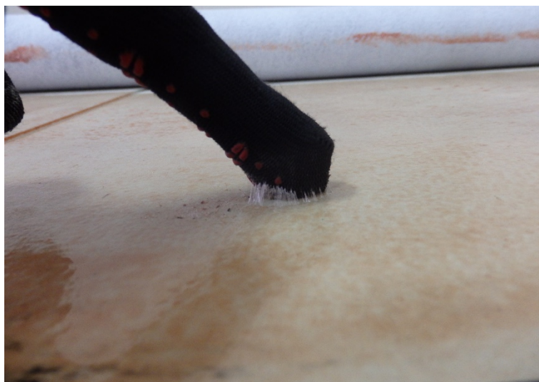
Рис. 5.11 Проверка высыхания клея
