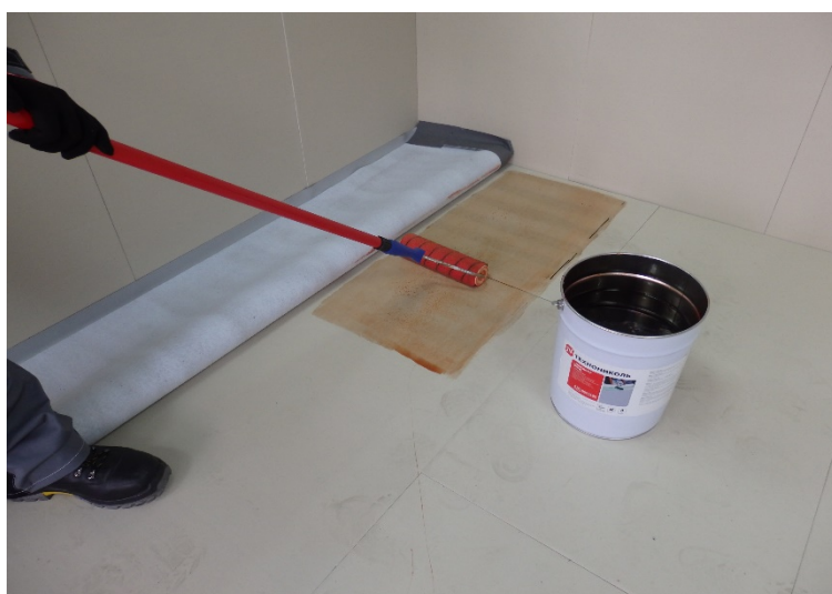
Рис. 5.10 Нанесение клея на поверхность теплоизоляции
