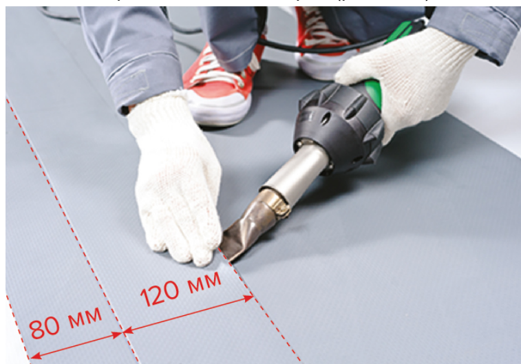
Рис. 5.19 Точечная прихватка мембраны
