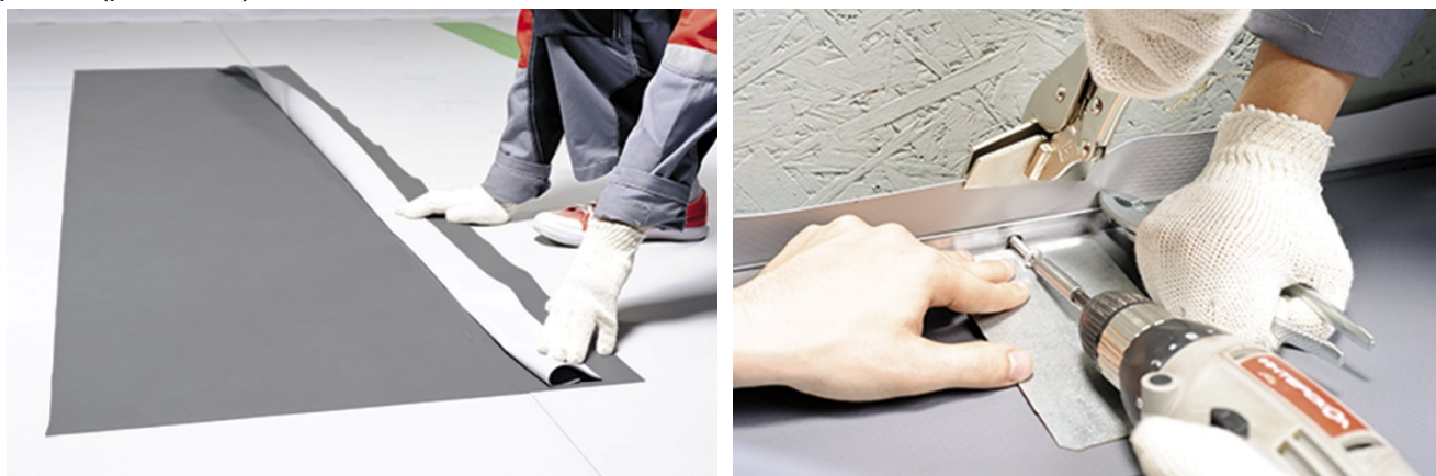
Рис. 5.21 Монтаж краевой рейки в скрытый карман
