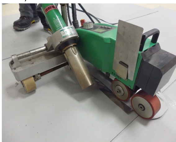
Рис. 5.14 Соединение стыков рулонов ПВХ-мембран с флисовой подложки при помощи ПВХ-мембраны без флисовой подложки
