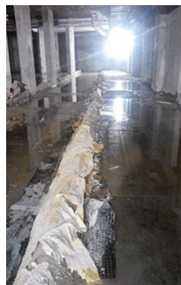
Рис. 1. Пример многоосного растяжения от негативного давления воды на гидроизоляционный материал, размещенный в области деформационного шва в конструкции фундамента
