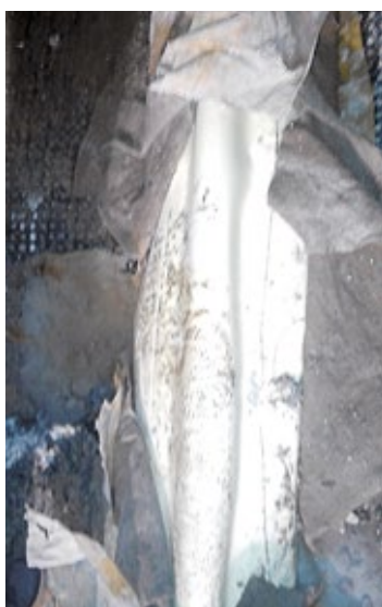
Рис. 1. Пример многоосного растяжения от негативного давления воды на гидроизоляционный материал, размещенный в области деформационного шва в конструкции фундамента
