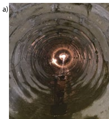
Рис. 2. Пример установки полимерной рулонной гидроизоляции при отрицательном давлении воды
