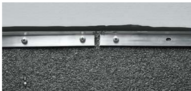
Рис. 3.21. Зазор между краевыми рейками
