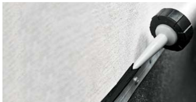
Рис. 3.24. Герметизация края краевой рейки
