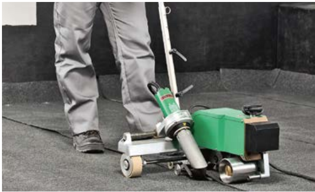
Рис. 3.45. Сварка шва автоматическим оборудованием
