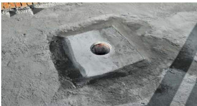
Рис. 3.12. Локальное понижение в месте установки воронки
