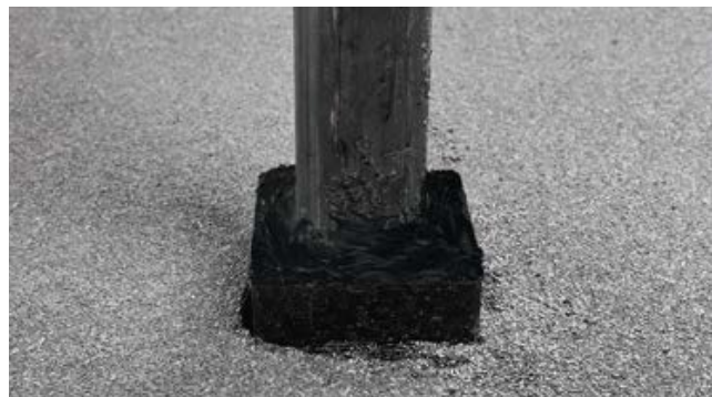
Рис. 3.37. Примыкание кровли к трубам малого диаметра
