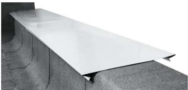
Рис. 3.29. Установка парапетной крышки
