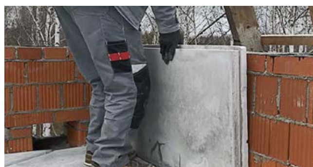
Рис. 3.15.а. Обшивка сэндвич-панелями ТЕХНИКОЛЬ Ц-ХПС CARBON вертикальной поверхности
