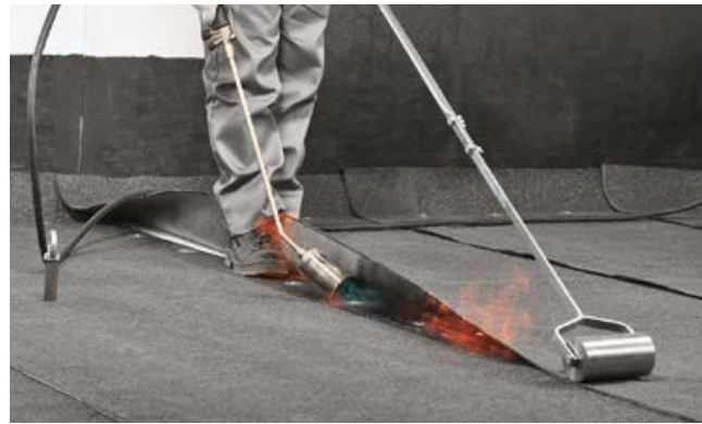
Рис. 3.46. Сварка шва с использованием газовой горелки
