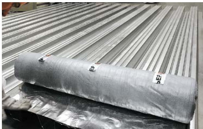
Рис. 3.5. Укладка пароизоляционного материала по профлисту
