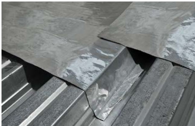
Рис. 3.6. Формирование продольного нахлеста пароизоляции на профлисте
