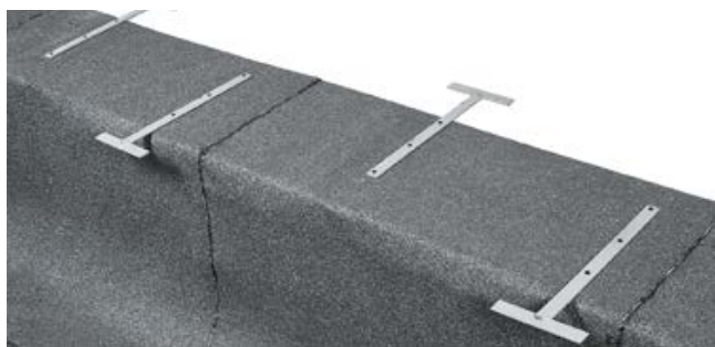
Рис. 3.28. Установка кровельных костылей
