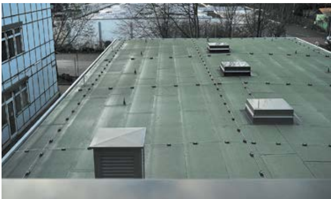
Рис. 3.56. Устройство молниеприемной сетки на кровле
