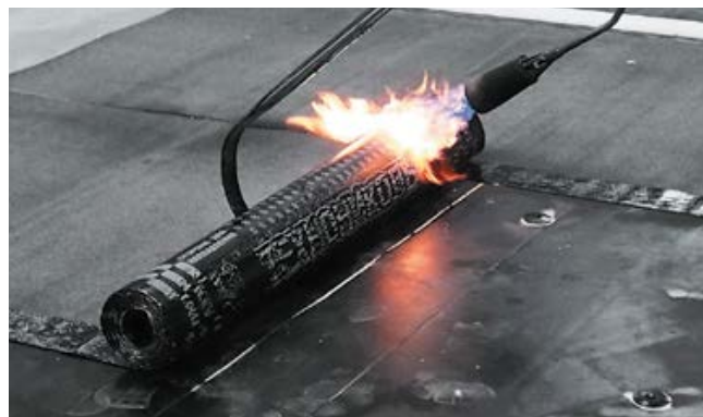
Рис. К.1. Наплавление по теплоизоляционным плитам
