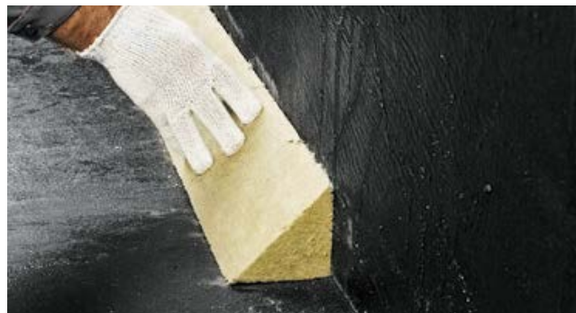
Рис. 3.13. Устройство наклонного бортика
