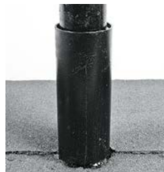
Рис. 3.33. Примыкание кровли к трубе
