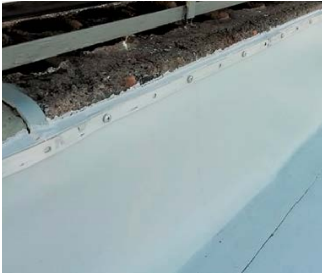
Примыкание к вертикальной поверхности
