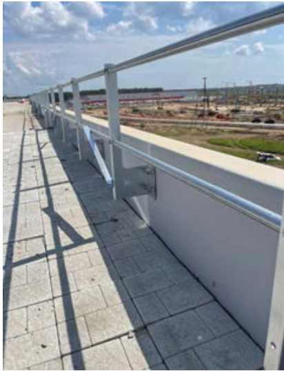
Установка ограждений ТН на парапет
