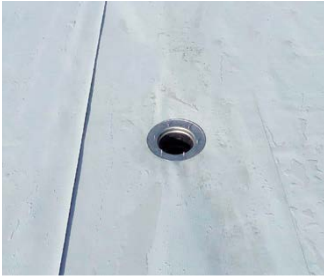
Устройство водоприемной воронки
