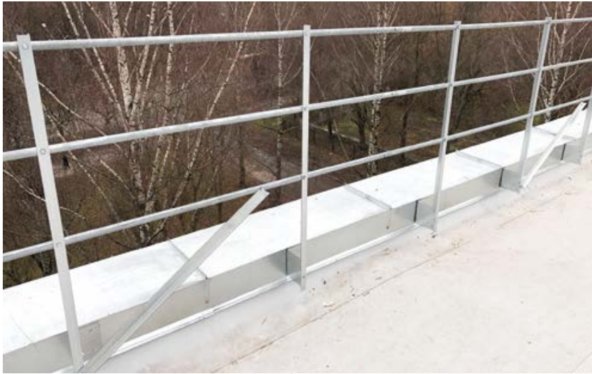
Установка ограждений ТН на парапет
