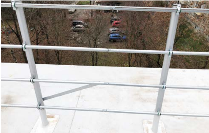
Установка ограждений (крепление в брус)
