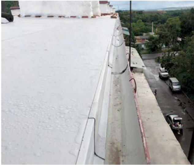
Устройство карнизного свеса
