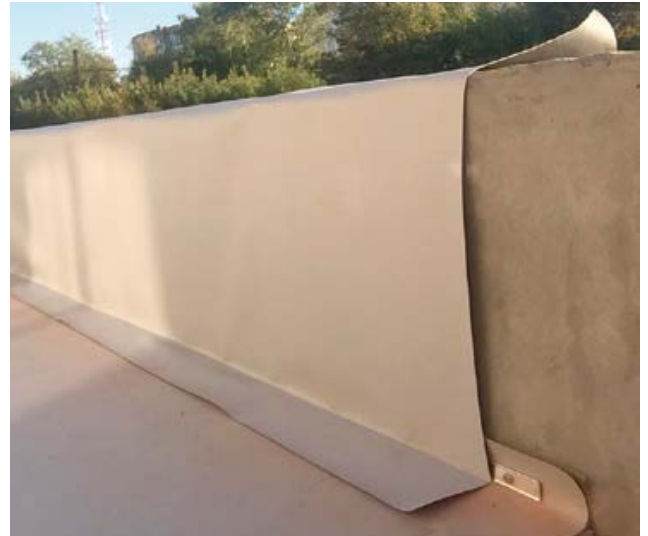
Примыкание к вертикальной поверхности с заведением ПМ за парапет
