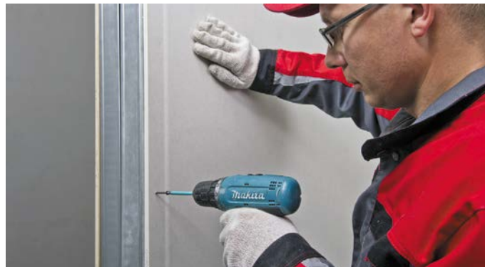
Рис. 13. Обшивка стен листами ГКЛ
