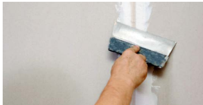
Рис. 8. Заделка швов
