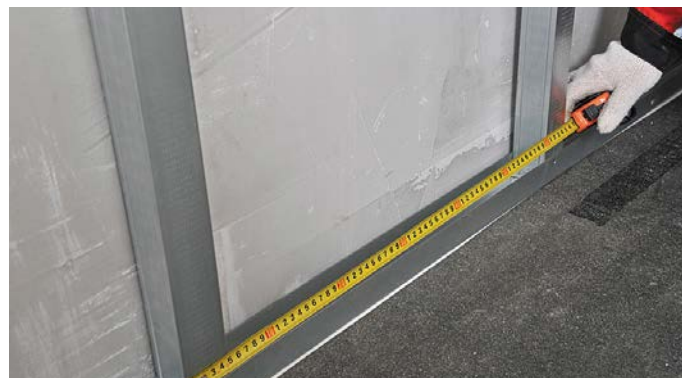
Рис. 11. Установка направляющего и стоечного профилей
