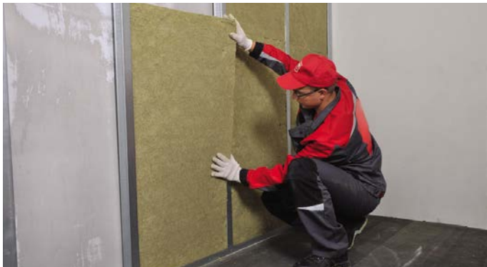
Рис. 12. Монтаж тепло-, звукоизоляционных плит
