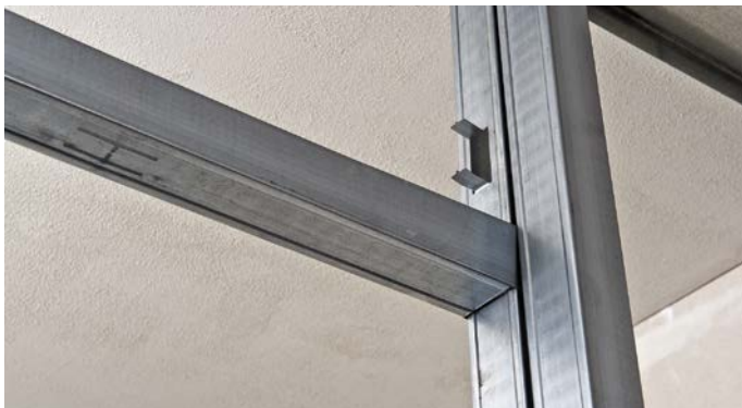
Рис. 4. Установка стоечного профиля (продолжение)
