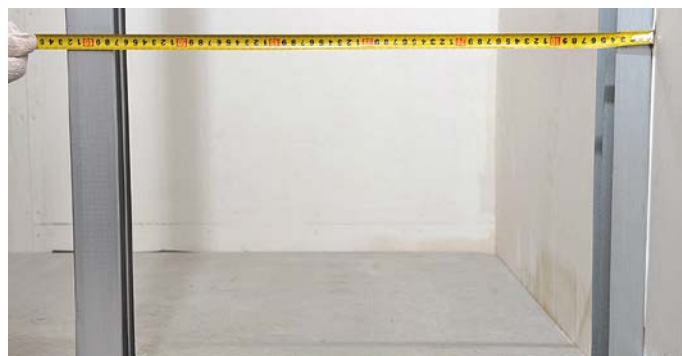
Рис. 4. Установка стоечного профиля
