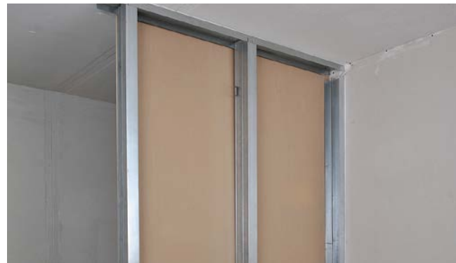
Рис. 5. Обшивка первой стороны перегородки листами ГКЛ
