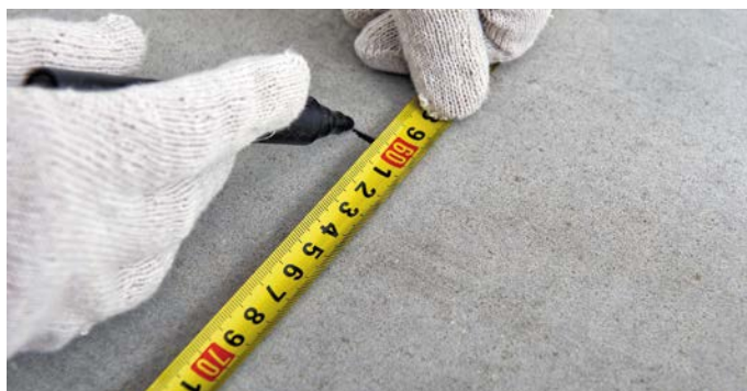
Рис. 2. Разметка основания
