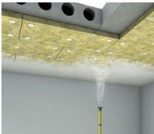
Рис. 7. Нанесение декоративного покрытия окрасочным оборудованием
