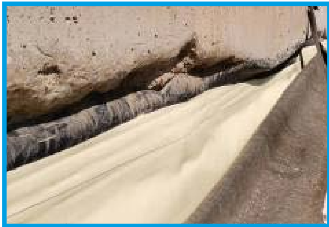
Рис. 10.4. Пример выполненного скругления монолитного бетона на участке примыкания гидрошпонки ЕС 320-4 и полимерной мембраны (с реального строительного объекта в Москве).
