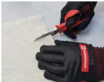
Второй заготовкой является геотекстиль с внутренним вырезом, повторяющим форму примыкания.
