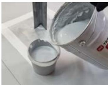
Далее добавляем акселератор LOGICROOF MAST-AKS в объеме 5-10% от массы мастики в зависимости от погодных условий (см. инструкцию на этикетке) и тщательно перемешиваем низкооборотной дрелью в течение 3-4 минут до однородной массы.
