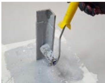
После полной полимеризации (в зависимости от погодных условий, см. инструкцию на этикетке) удалить малярный скотч. Примыкание готово.
