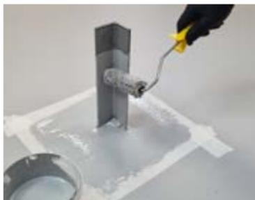
На первый слой мастики укладывается армирующий материал и прокатывается валиками по всей площади, чтобы обеспечить максимальную пропитку мастикой и равномерное прилегание. Армирование примыканий следует выполнять, начиная с вертикальной поверхности.
