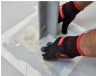
Второй слой мастики наносится поверх армирующего материала после того, как на первом слое образуется пленка, которая надежно зафиксирует полотно. Армирующий материал должен быть полностью покрыт вторым слоем мастики, что является критерием качества выполнения работ по нанесению второго слоя мастики.
