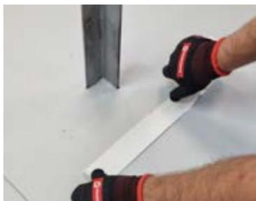
Праймер LOGICROOF MAST-PRIME равномерно наносим на подготовленное основание при помощи кисти или короткошёрстного валика.
