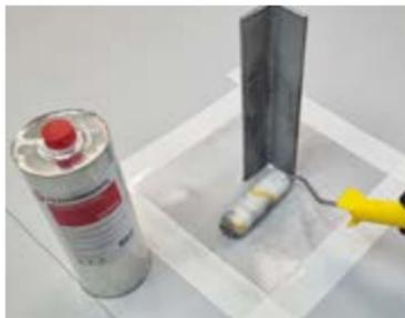
Также наносим праймер на поверхность примыкания.
