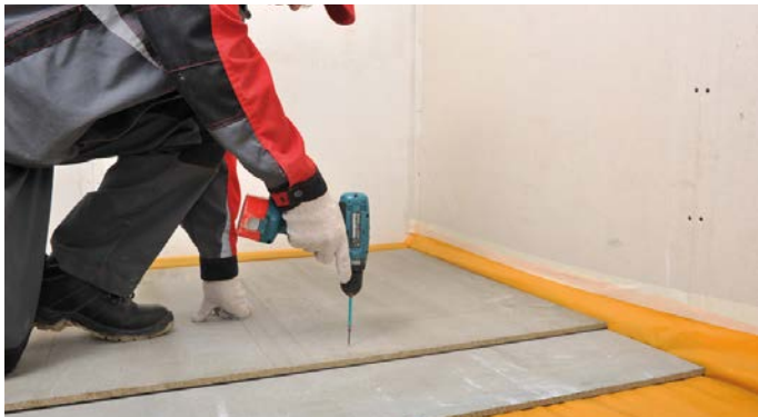
Рис. 9. Устройство сборной стяжки
