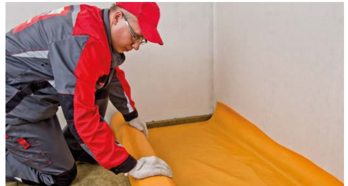
Рис. 8. Укладка гидроизоляции
