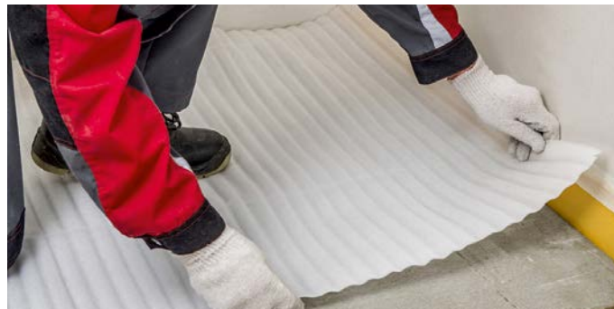
Рис. 12. Укладка подложки под финишное покрытие пола
