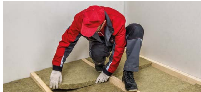
Рис. 2. Монтаж теплоизоляции враспор между лагами
