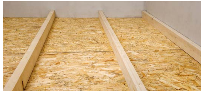
Рис. 1. Подшивка лаг снизу
