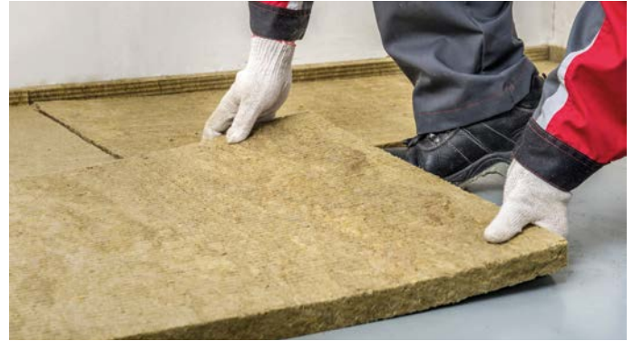
Рис. 7. Укладка плит ТЕХНОФЛОР СТАНДАРТ
