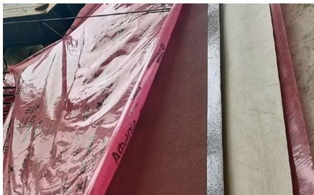
Рис. 7.14. Защита выступающей части гидроизоляционной системы перед бетонированием от загрязнения жидкими компонентами бетонной смеси
