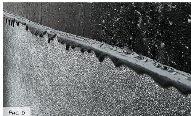
Рис. 2.2. Двухслойная гидроизоляционная мембрана Техноэласт Фундамент (рис. а) и однослойная гидроизоляционная мембрана Техноэласт Фундамент ТЕРРА (рис. б)
