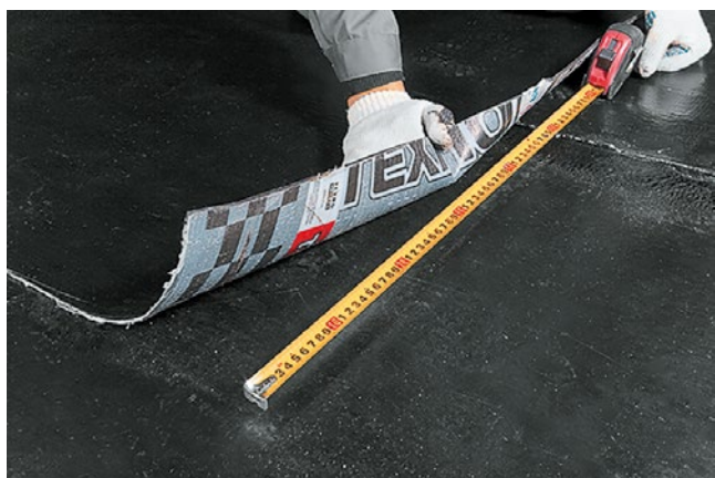
Рис. 4.13. Выставление нахлеста между рулонами первого и второго слоев
