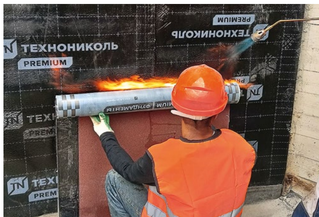
Рис. 7.11. Укладка второго слоя гидроизоляционной мембраны из битумно-полимерного рулонного материала Техноэласт Фундамент Адгезив
