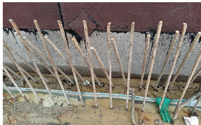
Рис. 7.14. Защита выступающей части гидроизоляционной системы перед бетонированием от загрязнения жидкими компонентами бетонной смеси
