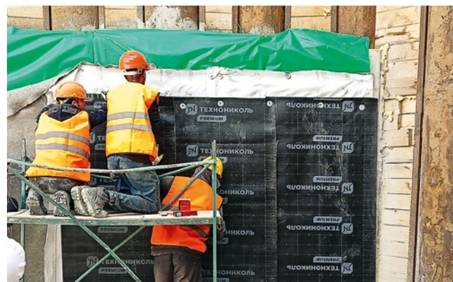
Рис. 7.9. Крепление первого слоя гидроизоляционной мембраны
