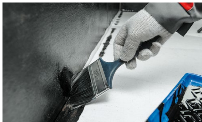
Рис. 3.7. Нанесение праймера кистью в зоне угла
