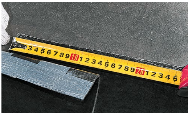
Рис. 4.4. Контроль торцевого нахлеста при укладке материала Техноэласт Фундамент
