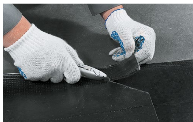
Рис. 4.5. Подрезка угла рулона в Т-образном шве
