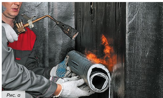
Рис. 2.2. Двухслойная гидроизоляционная мембрана Техноэласт Фундамент (рис. а) и однослойная гидроизоляционная мембрана Техноэласт Фундамент ТЕРРА (рис. б)
