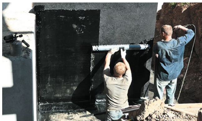
Рис. 4.17. Ручная и механическая подача рулона
