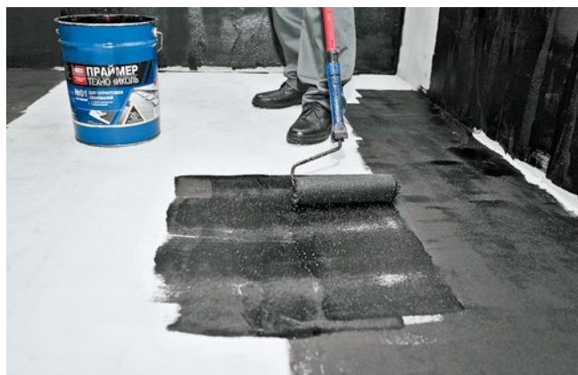
Рис. 3.5. Нанесение праймера
