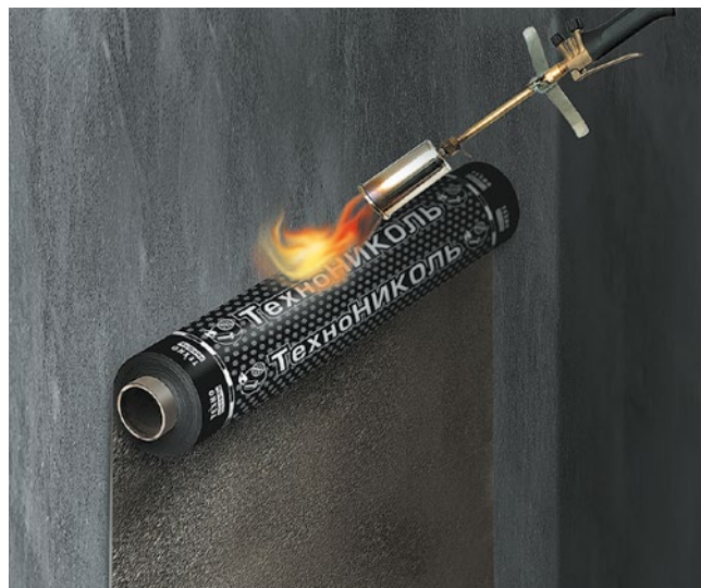
Рис. 4.18. Наплавление битумно-полимерного рулонного материала на вертикальную поверхность
