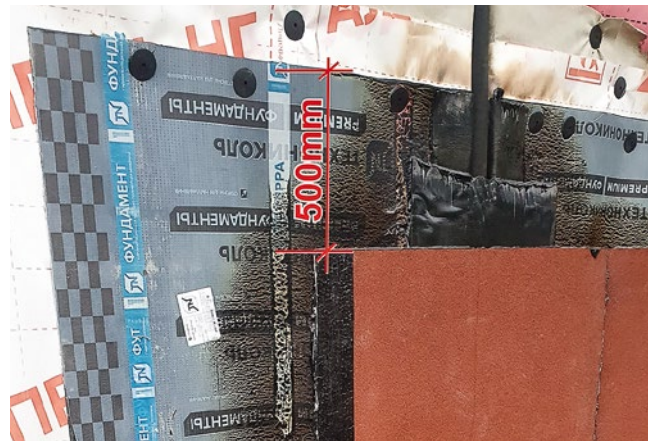
Рис. 7.11. Укладка второго слоя гидроизоляционной мембраны из битумно-полимерного рулонного материала Техноэласт Фундамент Адгезив
