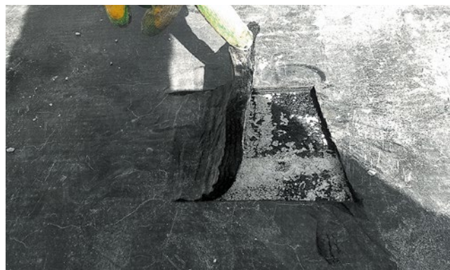
Рис. 4.1. Снижение адгезии материала к основанию из-за наличия пыли на огрунтованной поверхности
