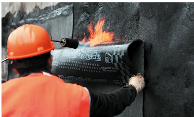
Рис. 2.3. Метод сплошного наплавления
