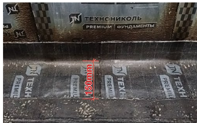
Рис. 7.10. Узел стыковки горизонтальной и вертикальной гидроизоляционной мембраны
