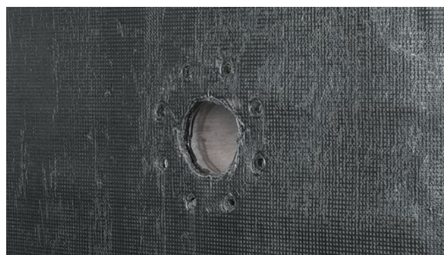
Рис. 6.12. Раскладка рулонов первого и второго слоя Техноэласт Фундамент в зоне трубной проходки
