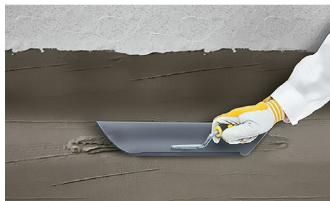
Рис. 3.3. Устройство выкружки
