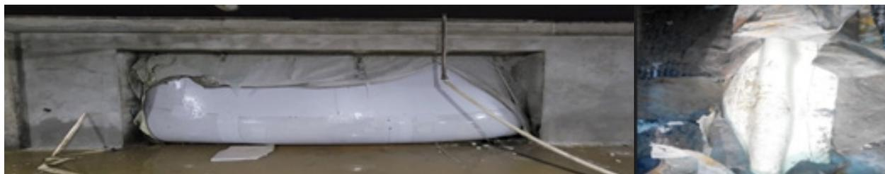
Рис. 2. а) Защитный экран из мембраны ECOBASE™ V-UV, выдерживающий давление напорной воды в зоне подземных конструкций; б) мембрана LOGICBASE™ V-SL, выдерживающая отрицательное давление воды в зоне деформационного шва
