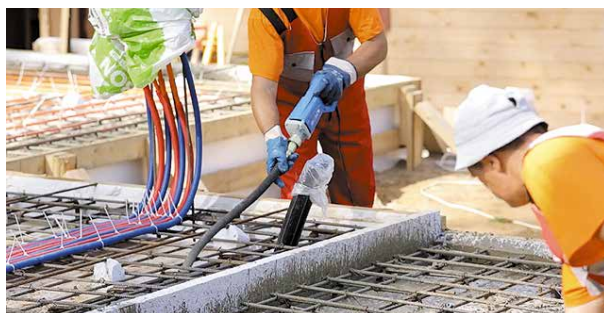
Вибрация бетонной смеси в ребрах жесткости.
