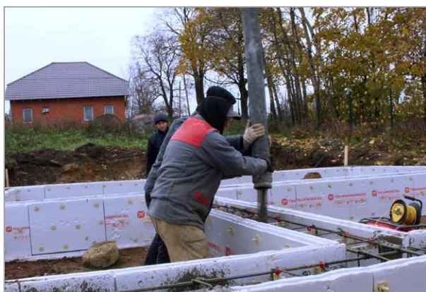
Подача бетона в опалубку при помощи бетононасоса.
