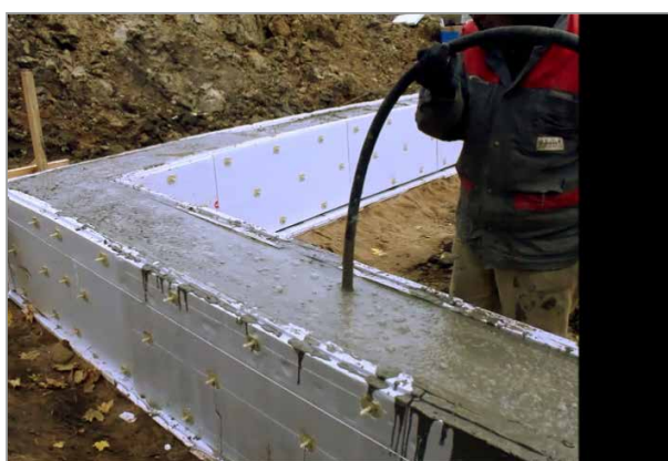
Виброуплотнение бетона с помощью глубинного вибратора.
