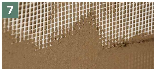
После монтажа плит теплоизоляции приступают к финишной отделке стен. На предварительно обработанную, фрезерованную поверхность плит наносят армирующий слой из штукатурки с сеткой (холсты сетки укладываются с нахлестом) и после высыхания – декоративный слой штукатурки.
