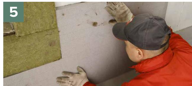
Для качественной приклейки плит придерживаются следующего правила: после нанесения клеевого раствора плиту прикладывают к месту установки с небольшим смещением и затем с давлением сдвигают до места установки.
