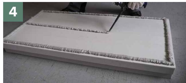
Клей-пена для пенополистирола наносится по периметру плиты и одной полосой по центру. Ширина полосы нанесения 2–3 см. После нанесения клей-пены для пенополистирола необходимо выждать 5–7 мин. до начала полимеризации и только потом приклеивать плиту к стене.
