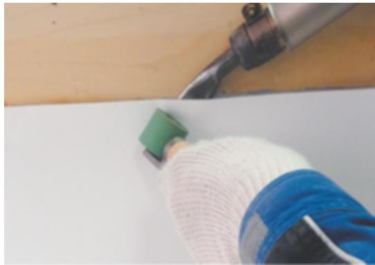
Для дополнительной герметизации узла нанесите ПУ герметик ТЕХНОНИКОЛЬ на край планки.
