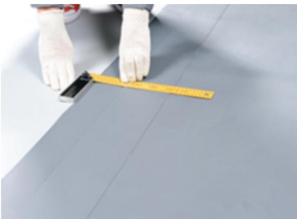
Подготовьте также узкую полосу армированной мембранны **V-RP** шириной **120 мм** для изготовления «кармана». На изнаночной стороне полосы «парапетной» мембранны начертите линию на расстоянии **80 мм** от нижнего края полотна и по ней выровняйте полоску для «кармана». Для получения «кармана» возможно использование специального готового элемента.
