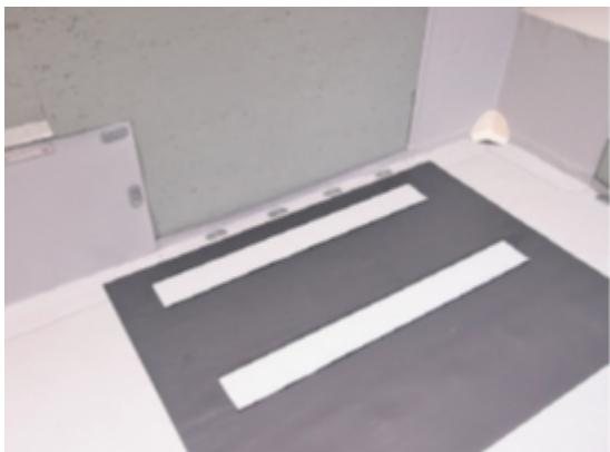
Поместите дополнительную рейку в кармане. При закреплении крайнего крепежа тяните мембранию за угол по диагонали, чтобы избежать образования волн на мембране.
