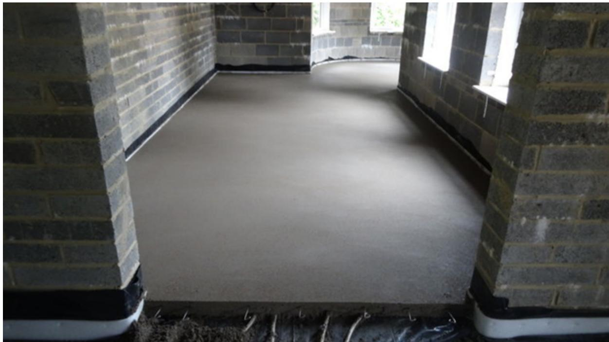
Монолитные однослойные стяжки укладываются в один слой по всей толщине. Как правило это цементо-песчаные смеси или растворы на цементной основе.
