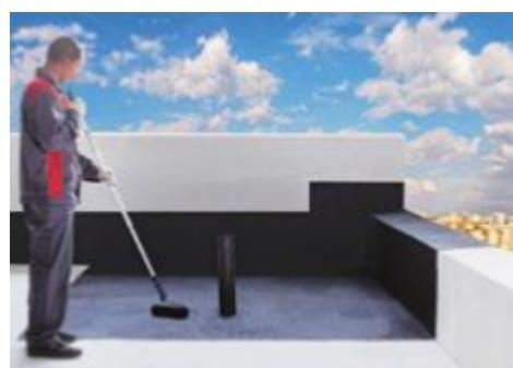
На вертикальной поверхности для аккуратного нанесения праймера используйте малярный скотч, наклеив его по разметке.
