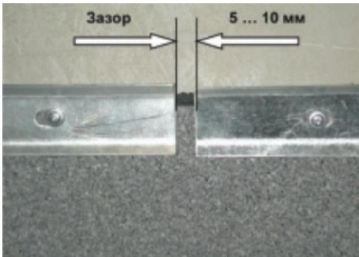
После завершения наклейки материала на примыкания и формирования всех внутренних и внешних углов, приступают к завершающей стадии выполнения кровли. Верхний край материала закрепляют с помощью металлической рейки. Рейку крепят саморезами с помощью электрошуруповерта. Расстояние между рейками по плоскости и в углах должно быть 5-10 мм.
