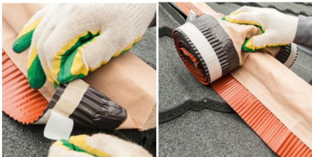
Полукруглые коньковые элементы на ребрах монтируйте снизу-вверх, укладывая их с нахлестом 2 см.
