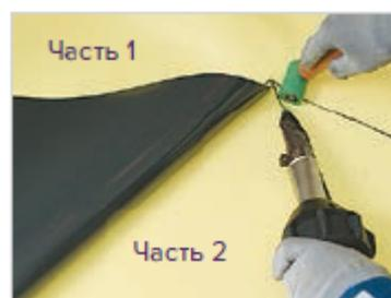
Переверните элемент. Проварите выпуски части 2 к части 1, начиная от края первой части и двигаясь к основанию угла.
