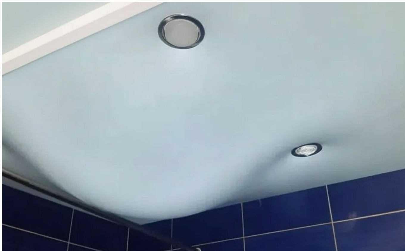
Натяжной потолок в ванной прогнулся из-за протечки сверху
