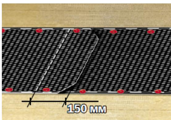
Сварите торцевой нахлест с помощью выбранного оборудования.
