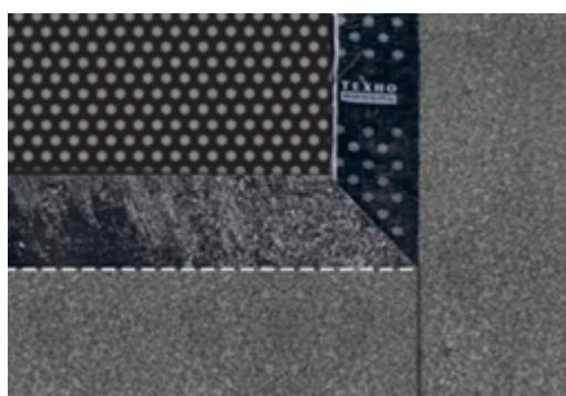
Торцевые нахлести соседних полотнищ кровельного материала Техноэласт ЭКП должны быть смещены относительно друг друга не менее чем на 500 мм:
