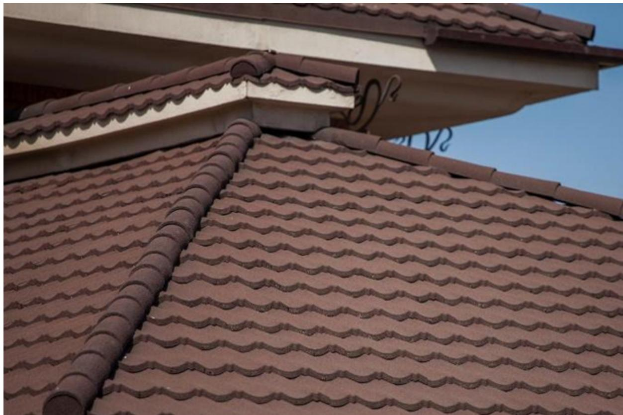
**Важно! Кровли из композитной черепицы следует устраивать на уклонах более 20% (12°).**
