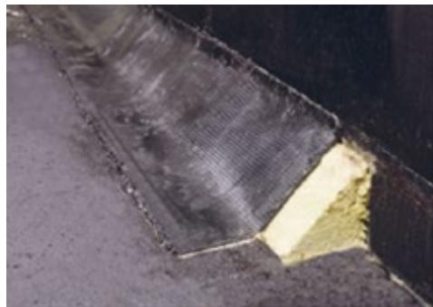
Наплавьте нижний слой из материала Техноэласт ЭПП. Материал подведите вплотную к наклонному бортику без заведения на галтель.
