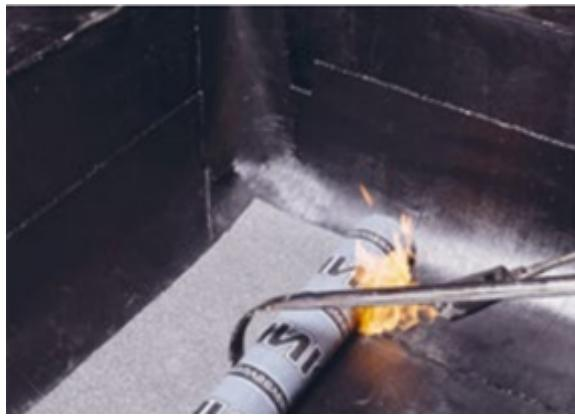
Подготовьте дополнительный верхний слой из материала Техноэласт ЭКП для заведения на плоскость парапета:
