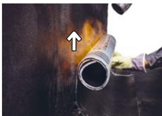
Наплавьте верхний слой из материала Техноэласт ЭКП.
