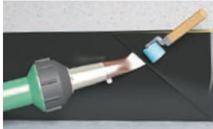
При стыковке выпуска горизонтальной гидроизоляции, поднятой на вертикаль, и вертикальной гидроизоляции следует соблюдать нахлест не менее 10 см при сварке автоматическим аппаратом. При этом особое внимание следует уделить герметичности сварки в месте пересечения приваренного к вертикали «кармана» и нижней кромки вертикальной гидроизоляции.
