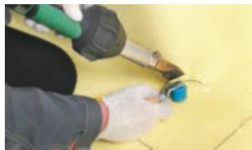
Тщательно проварите остальную площадь заготовки. Используйте широкий силиконовый ролик.
