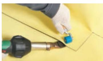
Вырежьте заготовку мембранны LOGICBASE V-SL таких размеров, чтобы она не менее чем на 50 мм перекрывала места разреза.
