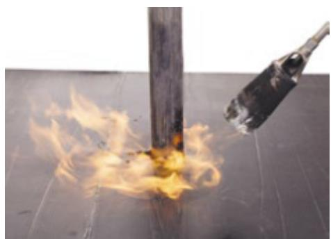
Установите стакан и вдавите фланец в разогретый материал. Следите за равномерным вытеком битумно-полимерного вяжущего из-под фланца стакана. Вытек обеспечит полную герметичность соединения.
