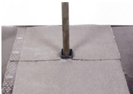
Заполните пространство между трубой и стенками стакана герметиком двухкомпонентным полиуретановым ТЕХНОНИКОЛЬ № 2К.
