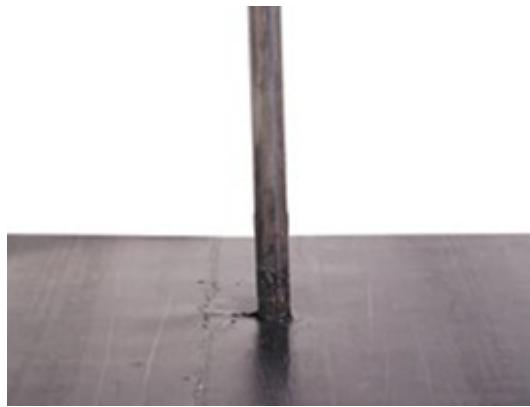
Разогрейте пламенем горелки область материала под установку фланца стакана.
