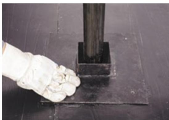
Закрепите металлический стакан в основание, используя минимум 4 крепежных элемента. В качестве крепежных элементов применяйте остроконечные саморезы ТЕХНОНИКОЛЬ EDS-S 4,8 мм с полиамиидной гильзой.
