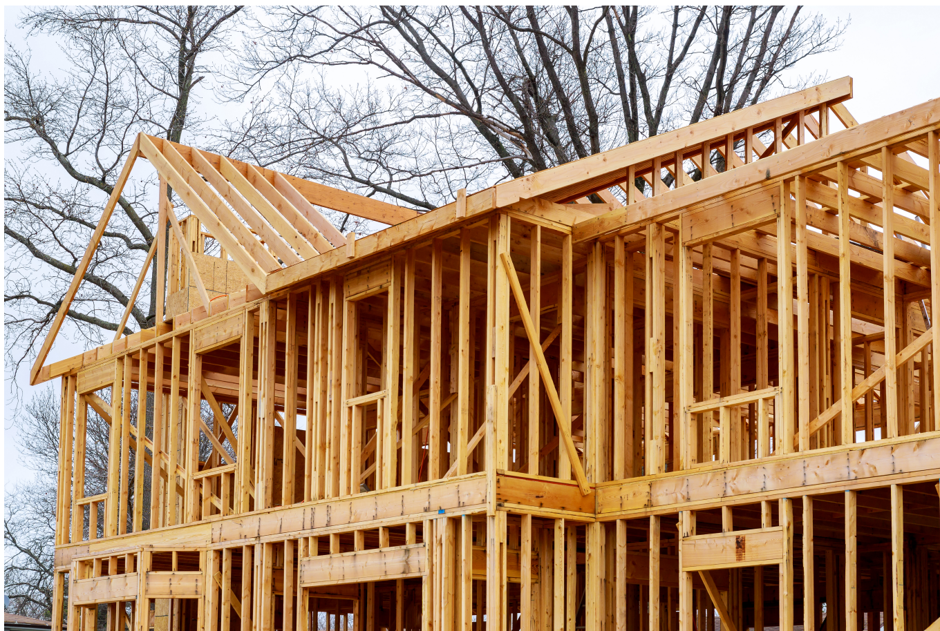
Рис. 19 Каркасно-панельный дом по технологии платформа (Platform-Frame)
