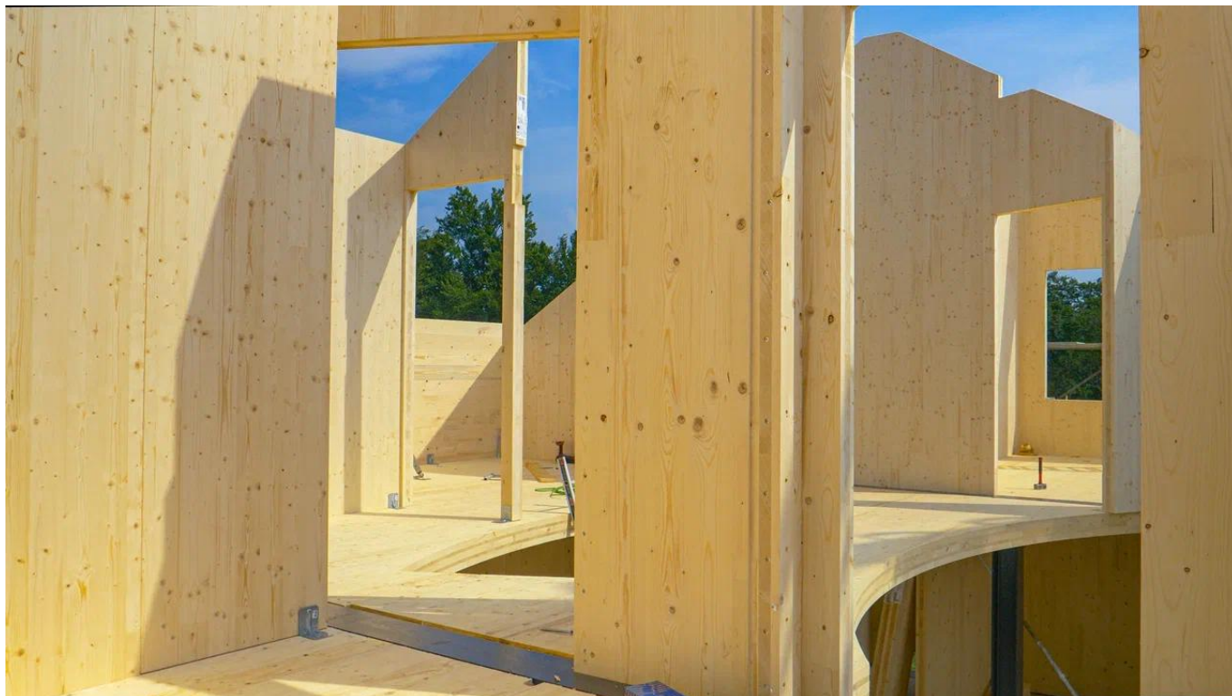
Рис. 28 Сборка дома из ДПК-панелей
