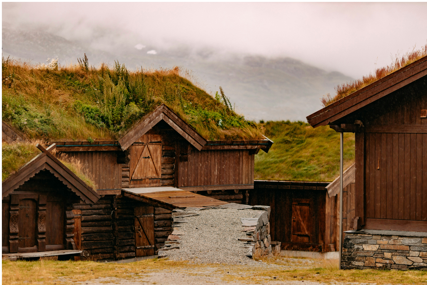
Рис. 15 Норвежский каркасный дом (Stavlaft)
