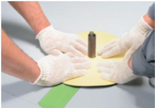
Прихватите заготовку точечно в нескольких местах. Снимите фаску с краев заплатки на величину сварного шва (не менее **30 мм**).
