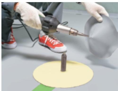
Быстрым движением, не допуская остывания мембранны, наденьте конус на элемент малого диаметра.
