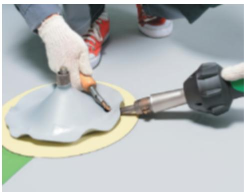
Приварите внешние края заготовки к основной мемbrane.
