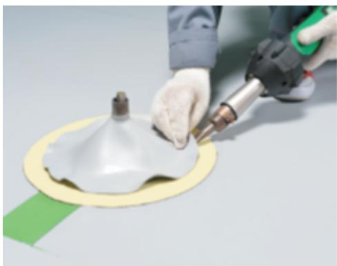
Сделайте воздушный карман с помощью латунного ролика. При этом давите латунным роликом «наружу», чтобы обеспечить необходимое натяжение мембранны.
