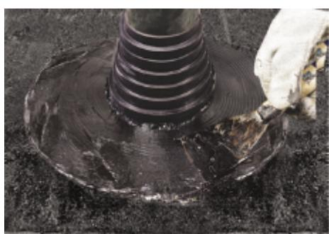
Подготовьте и наплавьте слой усиления. Слой усиления должен перекрывать юбку
