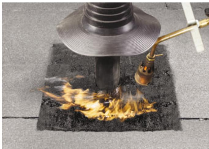
Юбку уплотнителя можно установить на предварительно разлитую на поверхность материала горячую мастику ТЕХНОНИКОЛЬ №41 («Эврика») или нанесенную шпателем герметизирующую мастику ТЕХНОНИКОЛЬ №71.
