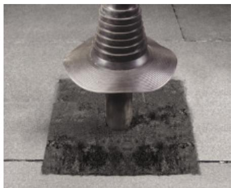
Обрежьте уплотнитель под выбранный диаметр трубы.
