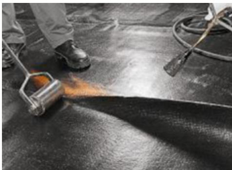
При необходимости наплавьте второй слой РБМ методом полной приклейки к первому слою, соблюдая расстояние между краями рулона первого и второго слоя (не менее 300 мм), а также боковые и торцевые нахлести.
