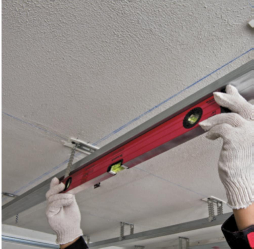
Согласно размеченным осям направляющий профиль закрепляется по периметру с шагом 500 мм.
