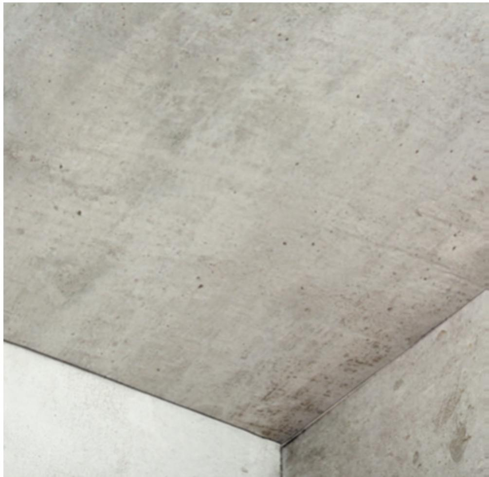
**ВАЖНО!** При выполнении работ, основание должно быть твердым, ровным, сухим. Следует устранить ослабленные включения, трещины, загрязнения, масляные пятна. Влажность в помещении не должна превышать 5-6%.
