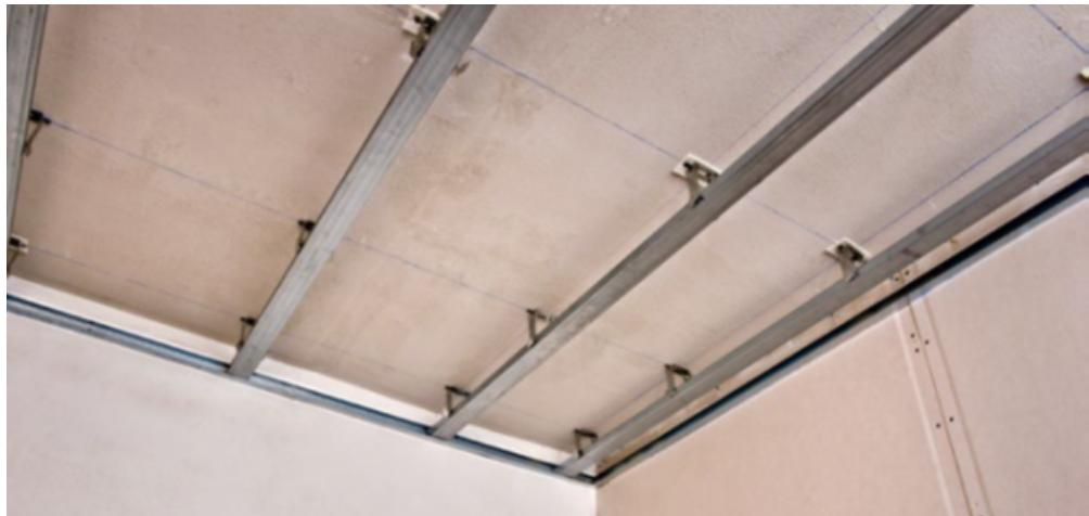
Потолочный профиль крепится к направляющему заклепками с обеих сторон. Шаг установки профиля — 600 мм. Для упрочнения системы устанавливается второй ряд профилей перпендикулярно первому.
