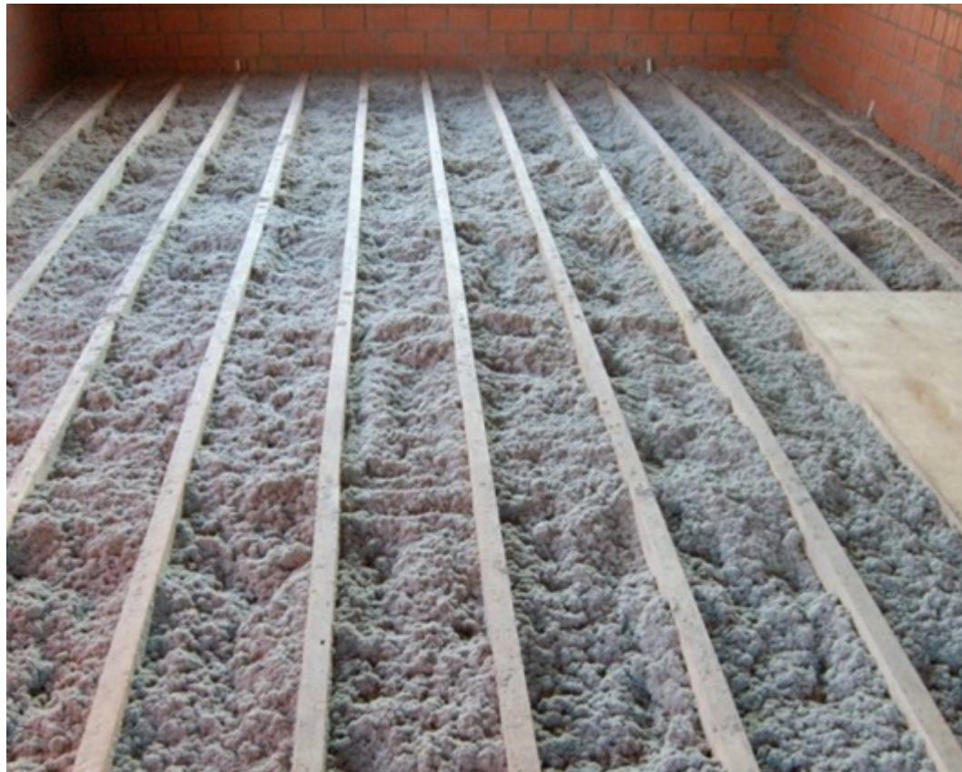
Данный материал похож по химической составляющей на PIR утеплитель, но при этом важно учитывать, что при распылении структура утеплителя не однообразна, что влияет в худшую сторону на теплопроводность.
