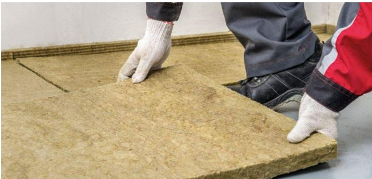
Каменная вата отличается высокими тепло- и звукоизолирующими свойствами, отличной водоотталкивающей способностью, огнестойкостью, сопротивляемостью механическим воздействиям.
