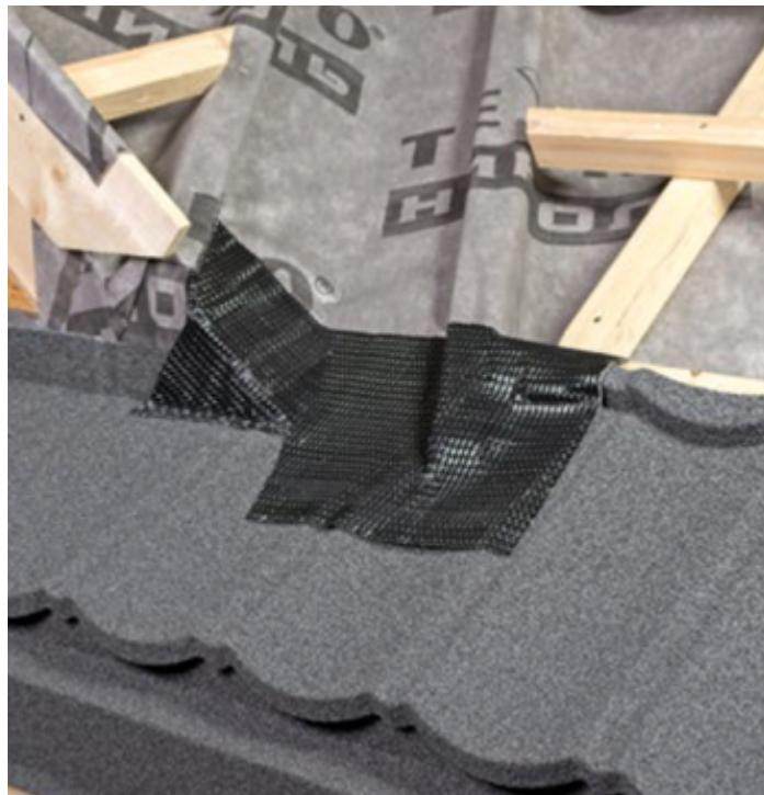
В качестве водосборного элемента используйте профилированную полосу из горячеокрашенного алюминия.
