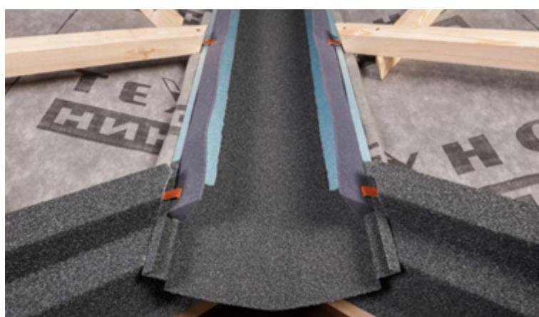
Первый элемент ендовы заведите на нижнюю полку капельника. Выходящую за пределы капельника часть элемента ендовы подрежьте и загните вниз. Каждый вышележащий элемент ендовы заведите в нижележащий и зафиксируйте при помощи кляммеров. Все нахлести на величину 15-20 см организовывайте по принципу каскадности воды. На бортах (слева и справа) лотков ендовы наклейте специальный поролоновый уплотнитель.
