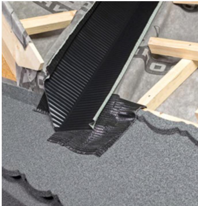
Полученный желоб закрепите шестью кляммерами к контробрешетке при помощи кровельных оцинкованных гвоздей 2,8x25 мм.
