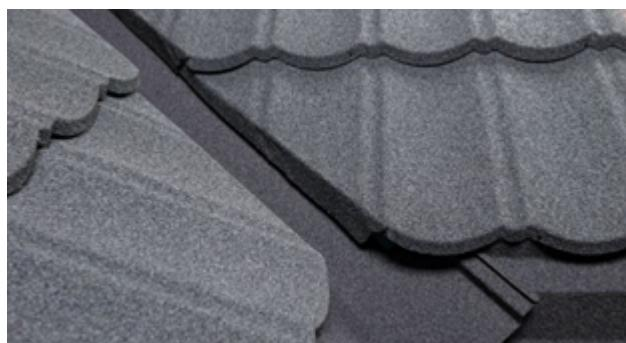
Панель композитной черепицы ТЕХНОНИКОЛЬ LUXARD заведите на элемент ендовы на 8 см и загните вниз так, чтобы расстояние между нижним отгибом композитной черепицы и
