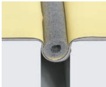
Поверх компенсатора уложите гидрошпонку для деформационных швов типа ЕМ.
