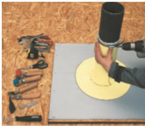
Затяните место примыкания металлическим хомутом.
