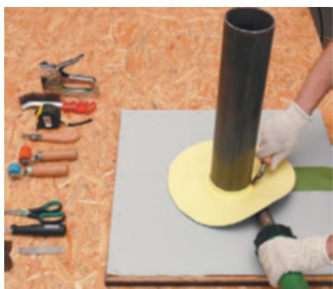
Приварите внутреннюю часть заготовки к основной мемbrane с помощью ручного фена.
