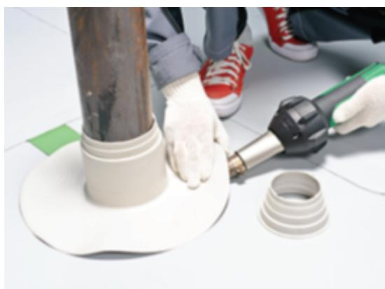
Приварите «юбку» готового элемента по «кругу» с помощью тефлонового или силиконового прикаточного ролика.
