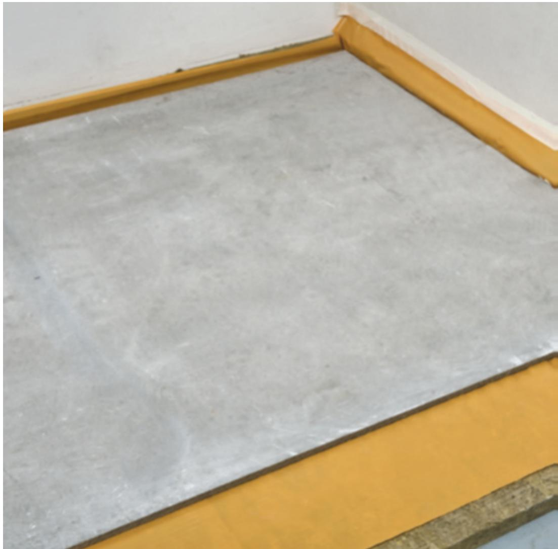
Необходимо уложить плиты ГКЛ/ЦСМ в 2 слоя поверх плит ТЕХНОФЛОР, соблюдая разбежку швов. Стяжка должна примыкать к заранее нарезанным и установленным полосам из каменной ваты ТЕХНОФЛОР.
