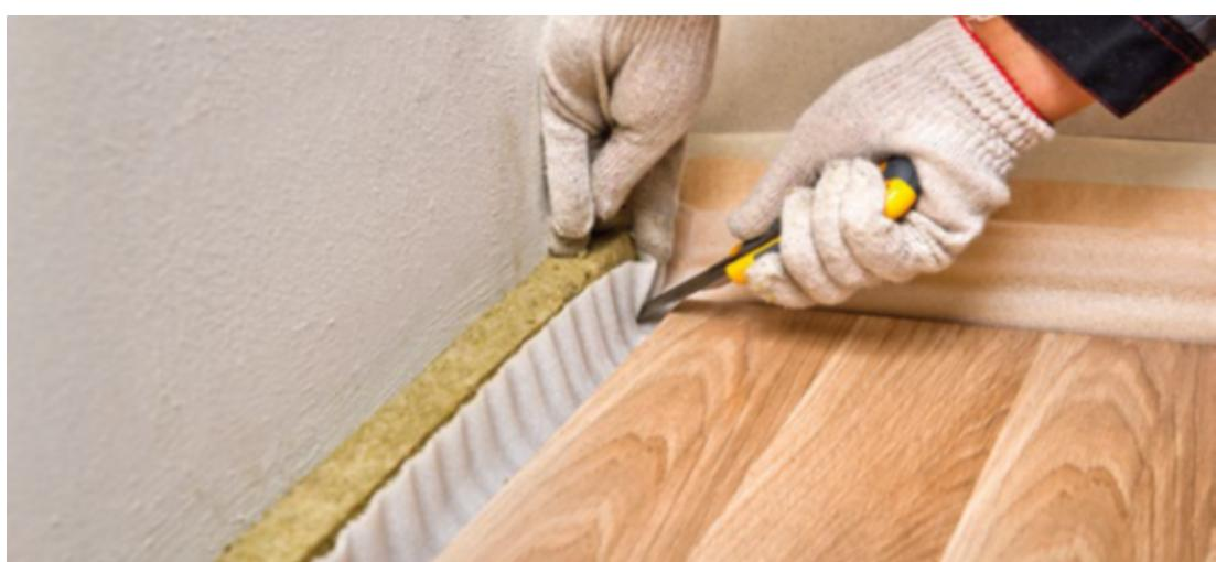
Подрезка звукоизоляционных плит по периметру на уровне чистого пола при установке узкого
