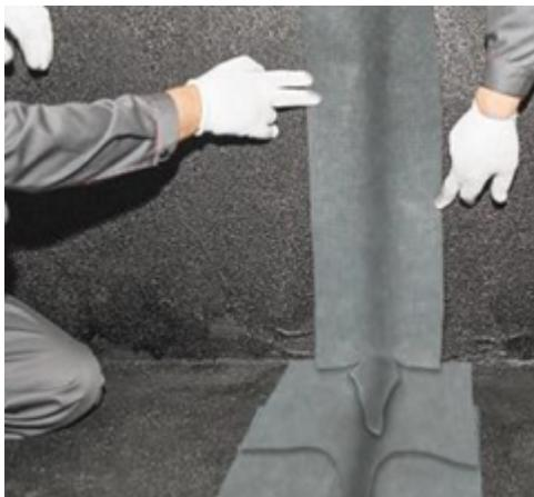
Соедините узел стыка с рулоном горизонтального шва с соблюдением нахлеста 150 мм. Затем сделайте то же самое на вертикальной поверхности.
