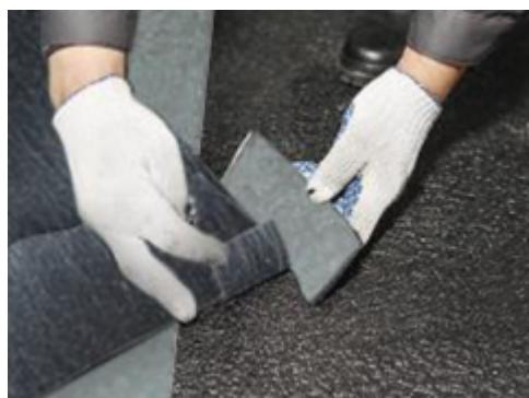
Узел стыка с наплавленной пятойкой должен выглядеть следующим образом.
