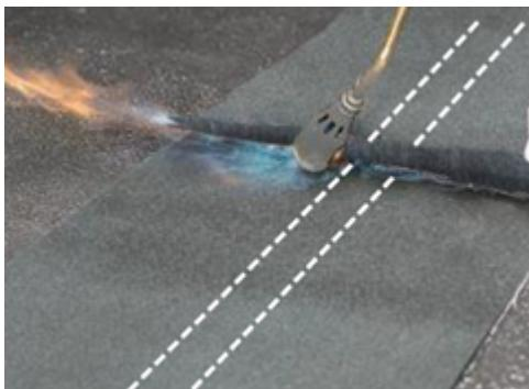
Наплавьте одну часть рулона (с одной стороны деформационного шва) на основание, сформируйте компенсаторную петлю, затем наплавьте вторую часть рулона на основание.
