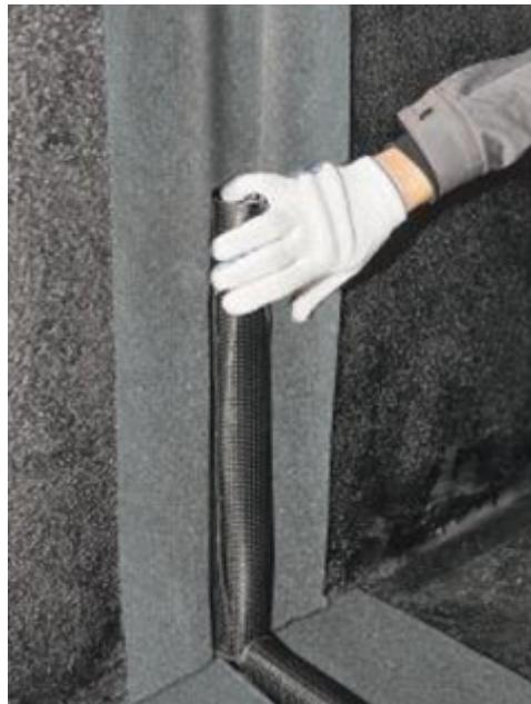
При необходимости прокатайте наплавленный материал силиконовым роликом.
