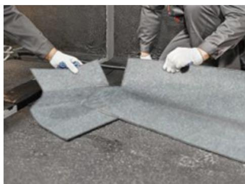
С внешней стороны стыка наплавьте пяточку для дополнительной герметизации узла.
