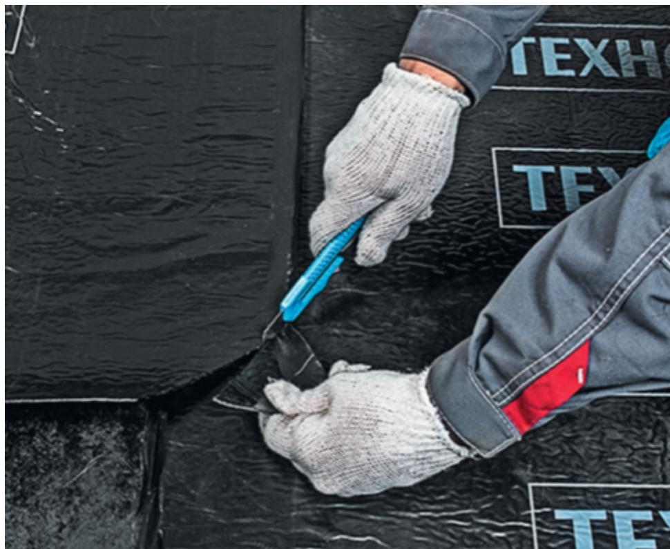
Для увеличения надежности и герметичности торцевого нахлеста подрежьте угол полотнища материала, находящегося в нахлесте снизу.
