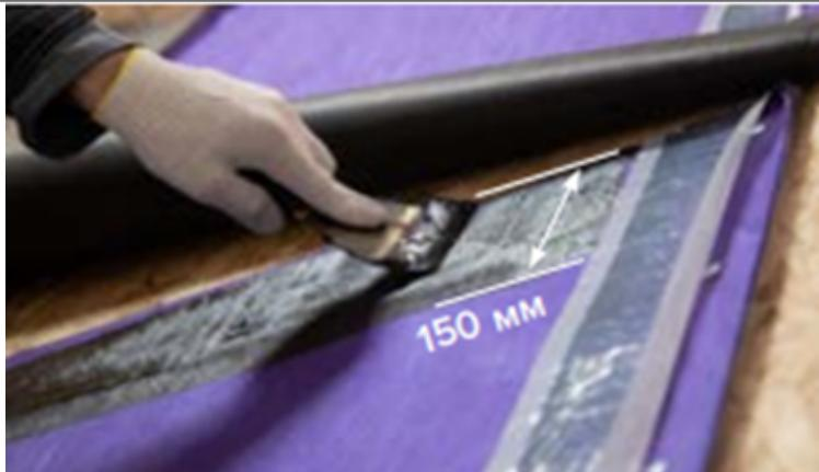
Места поперечных перехлестов механически закрепляемых подкладочных ковров обрабатываются битумной приклеивающей мастикой ТЕХНОНИКОЛЬ №23 (Фиксер). Толщина слоя нанесения мастики не более 1мм. Ширина поперечного перехлеста составляет 150мм.
