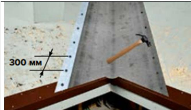
При температуре от 0 до +10 °C необходимо дополнительно закрепить подкладочный ковер кровельными гвоздями с широкой шляпкой. Расстояние между гвоздями составляет 300мм.
