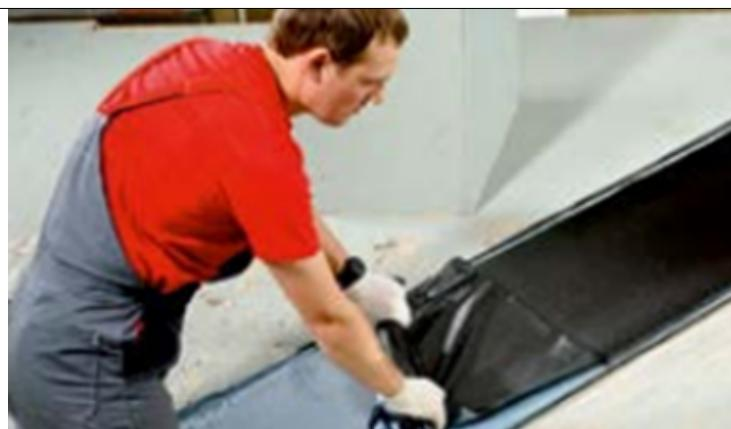
С одной части подкладочного ковра удаляется защитная пленка.
