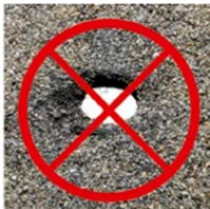
**ВАЖНО! Шляпка гвоздя должна плотно прижимать ковер к основанию, но не пробивать его. Перед непосредственным креплением подкладочного ковра гвоздем необходимо расправить и натянуть материал, чтобы на поверхности не было складок и неровностей.**
