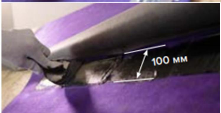
Продольный перехлест подкладочных ковров составляет 100мм. Места продольных перехлестов подкладочных ковров ANDEREP PROF и ANDEREP GL LIGHT промазываются битумной приклеивающей мастикой ТЕХНОНИКОЛЬ №23 Фиксер, толщиной не более 1мм
