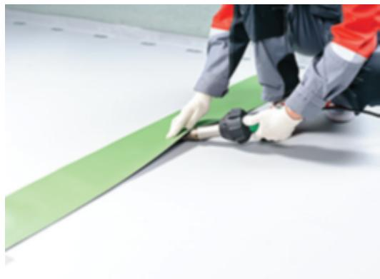
На основной длине приварите полосу к основному кровельному ковру автоматическим оборудованием.
