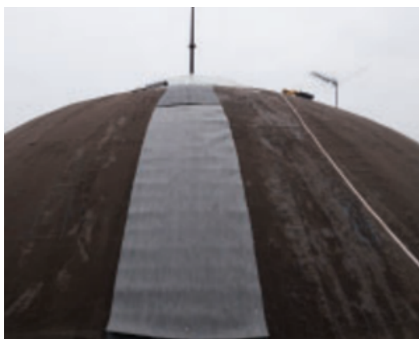
Аналогичным способом смонтировать последующие ряды подкладочного ковра.
