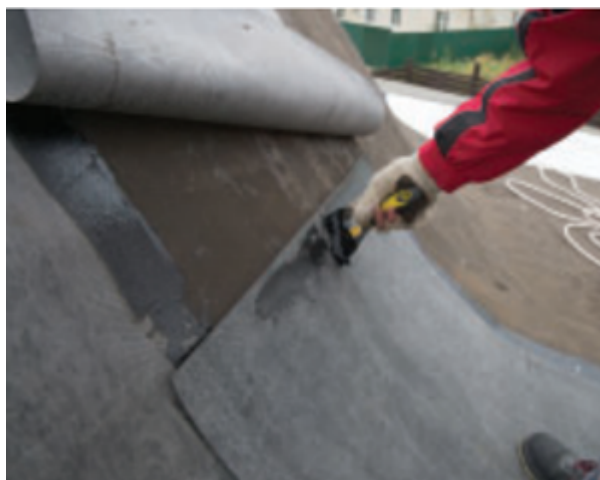
Первый смонтированный сектор подкладочного ковра.
