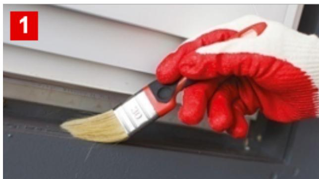
2. Рекомендуется увлажнить поверхность водой для улучшения сцепления пены и ускорения процесса полимеризации (только при положительных температурах). Пену нельзя наносить на поверхность, покрытую инеем или льдом!
