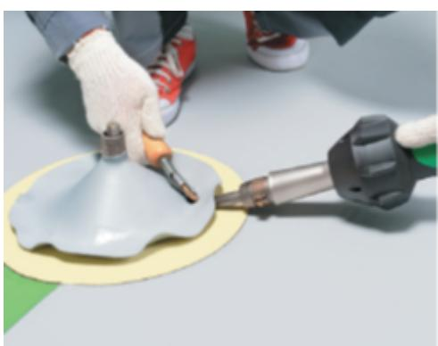
Приварите внешние края заготовки к основной мембране.
