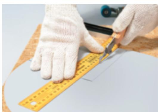
Закруглите углы с помощью ножниц.
