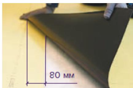
Сварите сформированный нахлест автоматическим сварочным аппаратом.
