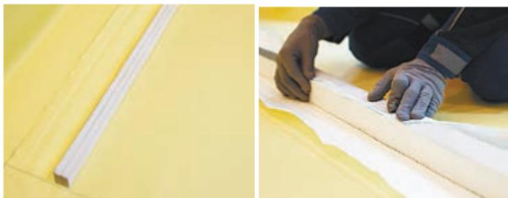
Для крепления геотекстиля или пленки используйте двусторонний скотч. При использовании вилатерма в качестве компенсатора оборачивать его не нужно.
