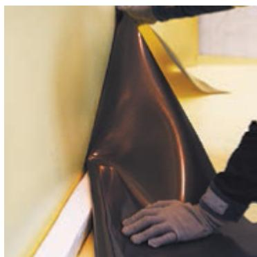
Приварите полосу усиления таким образом, чтобы она точно повторяла контур уложенного компенсатора.
